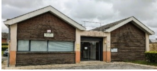
Réfection de la peinture du pignon de la maison de santé
