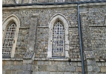
Enduit sur la façade nord pour endiguer l'humidité du mur de l'église et ainsi préserver les travaux de la sacristie
