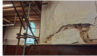
Réfection des enduits intérieurs de la sacristie, murs et plafond en totalité. Avec adaptation de la solution technique de rénovation pour respecter l'enveloppe financière prévue en 2025
