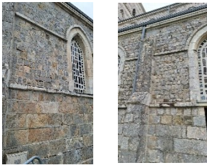
Enduit sur la façade nord pour endiguer l'humidité du mur de l'église et ainsi préserver les travaux de la sacristie
